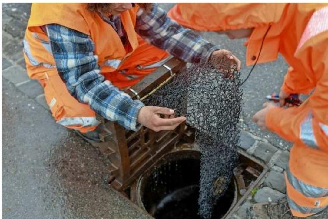
Figura 12 – Esempio di geotessile tridimensionale
