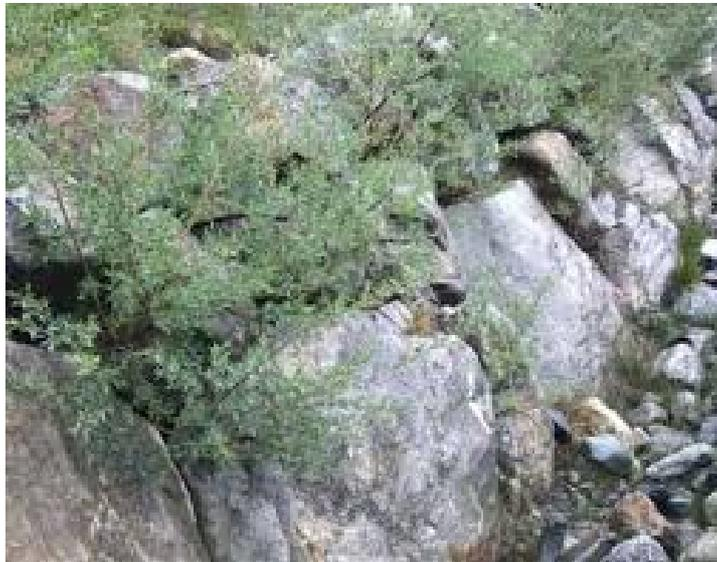
Figura 15 – Esempio di inserimento di talee in scogliera con funzione di consolidamento
