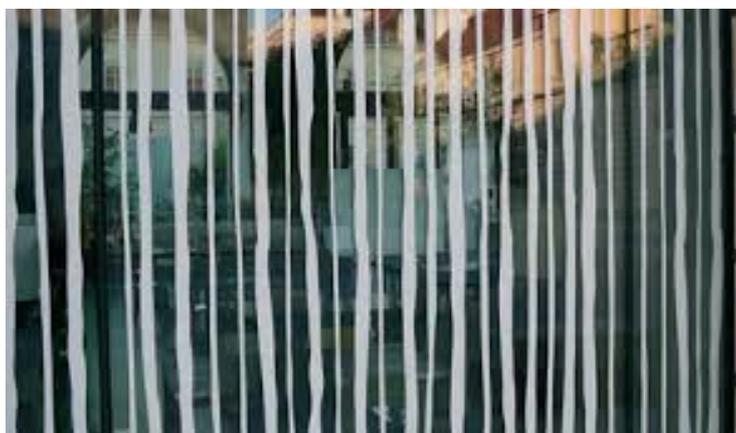
Figura 13 – Esempio di vetro serigrafato con motivi geometrici verticali
