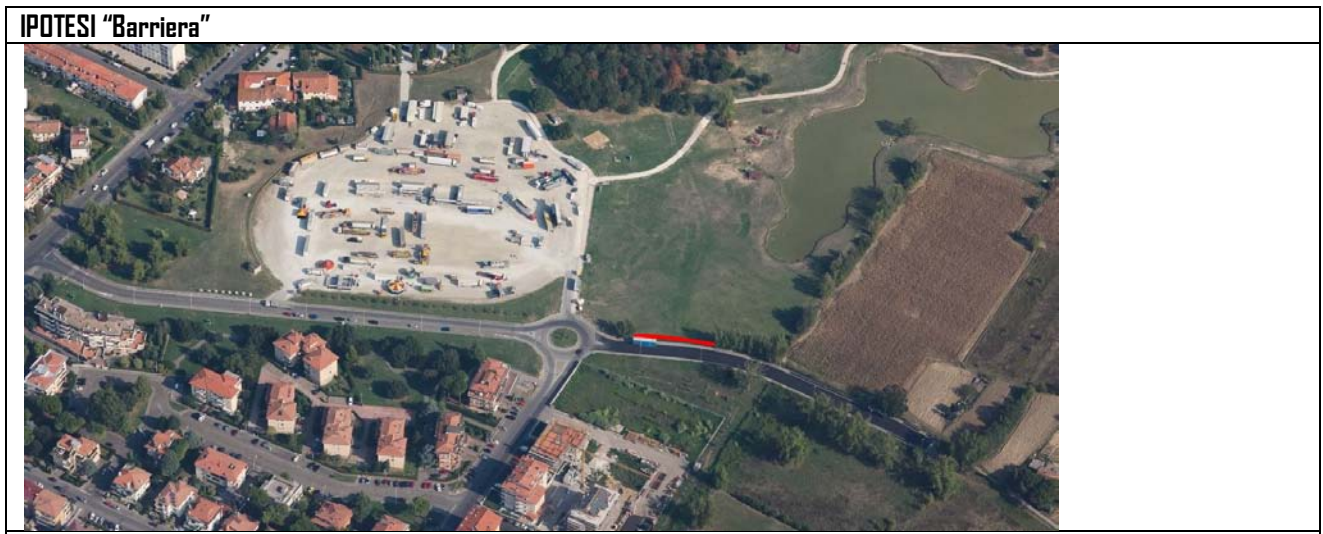
Il dimensionamento dello schermo acustico verrà effettuato con precisione mediante idoneo modello di simulazione nelle successive fasi di progettazione.
