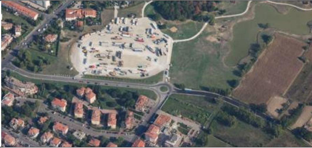
Il tratto già realizzato della strada
