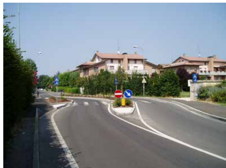
figura 2.27 Esempio di protezione 'forte' di attraversamento ciclabile in strada suburbana, con chicane di rallentamento ed isola centrale. [Reggio Emilia - foto Polinomia]
