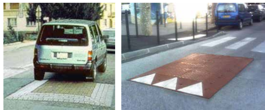
figura 2.32 Esempi di cuscino berlinese: il dispositivo di moderazione permette il passaggio in piano dei veicoli a due ruote.
