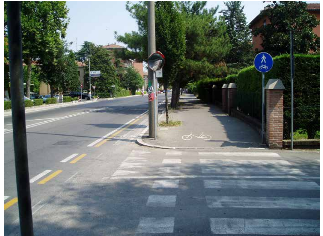
figura 2.5 La foto rende evidenti le differenze tra due soluzioni a differente grado di protezione. La pista protetta ricavata sul marciapiede sarà apprezzata dai ciclisti 'deboli' ma non utilizzata da quelli 'rapidi' che resteranno sempre in carreggiata, dove comunque potranno ben sfruttare la protezione offerta dalla semplice segnaletica. Si nota altresì come la banda gialla sia stata, irregolarmente quanto comprensibilmente, realizzata di larghezza ridotta [Reggio Emilia - Foto Polinomia]
