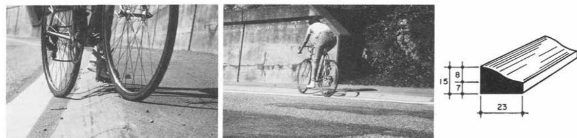
figura 2.30 Esempio di utilizzo di cordonature che permettono al ciclista di salire e scendere dal marciapiede con facilità in caso di ostacolo o pericolo ("Amenagements à l'usage des deux-roues" - Cantone di Berna, Direction des travaux publics)
