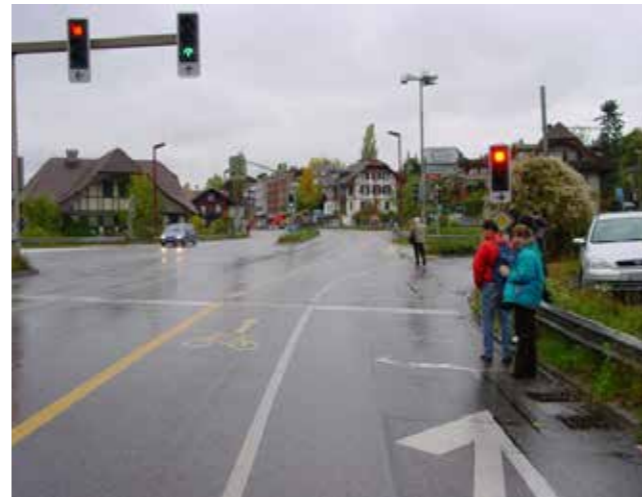
figura 2.21 Esempio di corridoi ciclabili di attestamento all'incrocio [Berna – Foto Polinomia]
