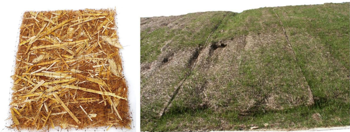
Figura 8: Biostuoia antierosione in paglia e cocco: prima della posa in opera e dopo 1 anno.
