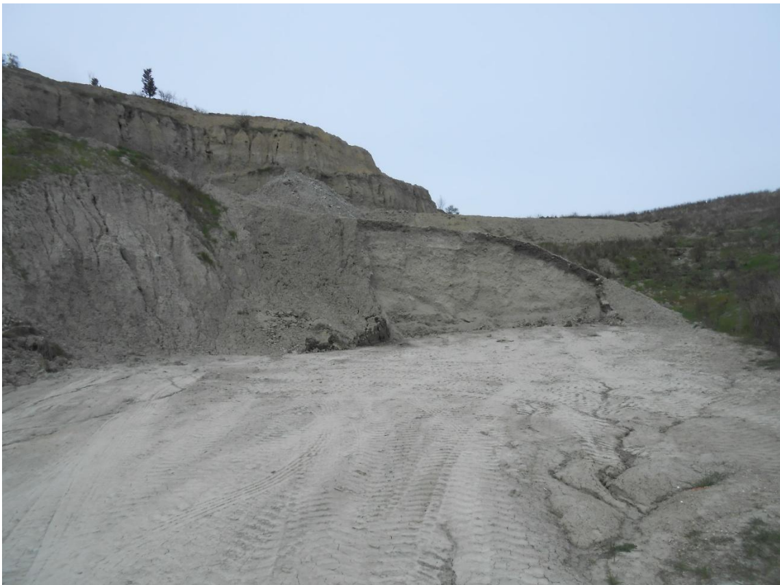
Fig. 2 – Fronte estrattivo di base
