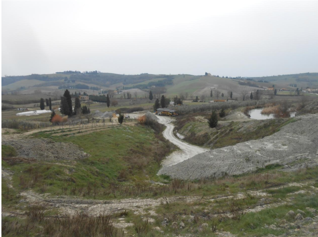
Fig. 5 – Vista panoramica da Nord dell'area servizi e del piazzale di base
