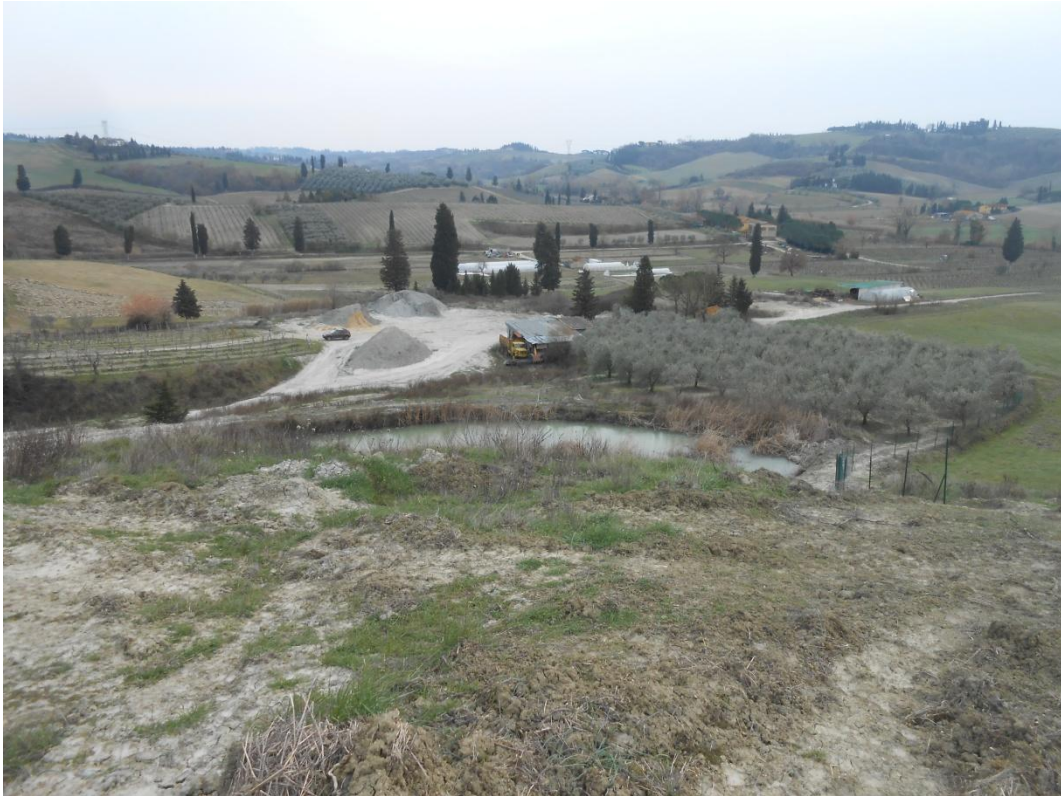
Fig. 7 - Vista panoramica dell'area servizi e dell'area ovest ripristinata ad oliveta
