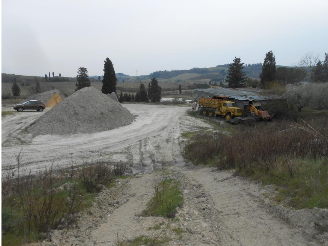
Fig. 11 – Piazzale di base ed area servizi
