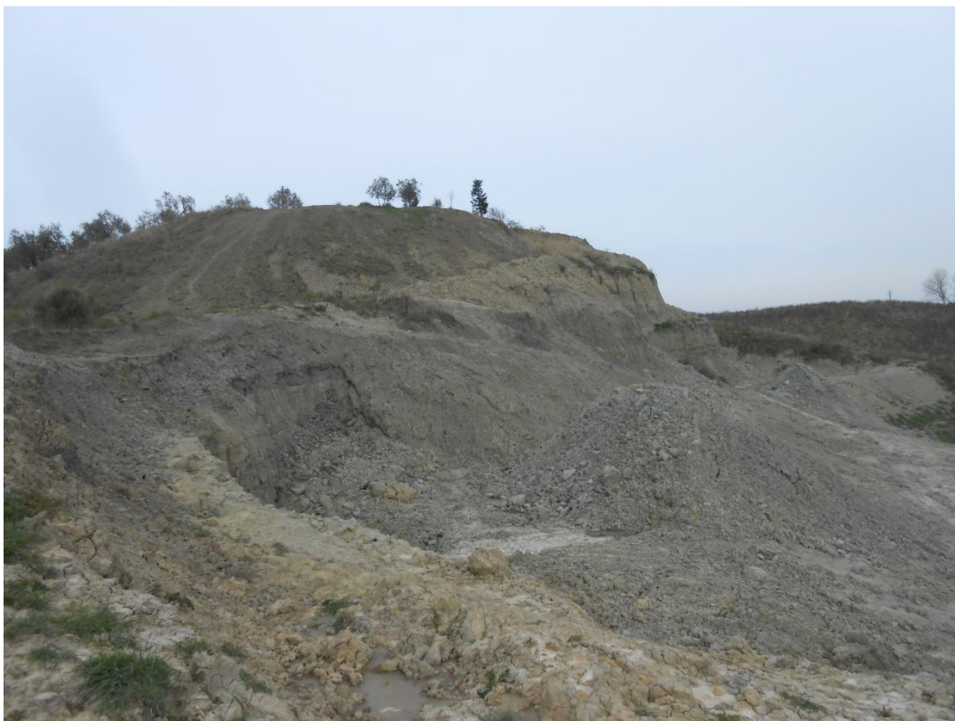
Fig. 8 – Dettaglio del fronte di estrazione perimetrale nord con piccolo cumulo di sterile
