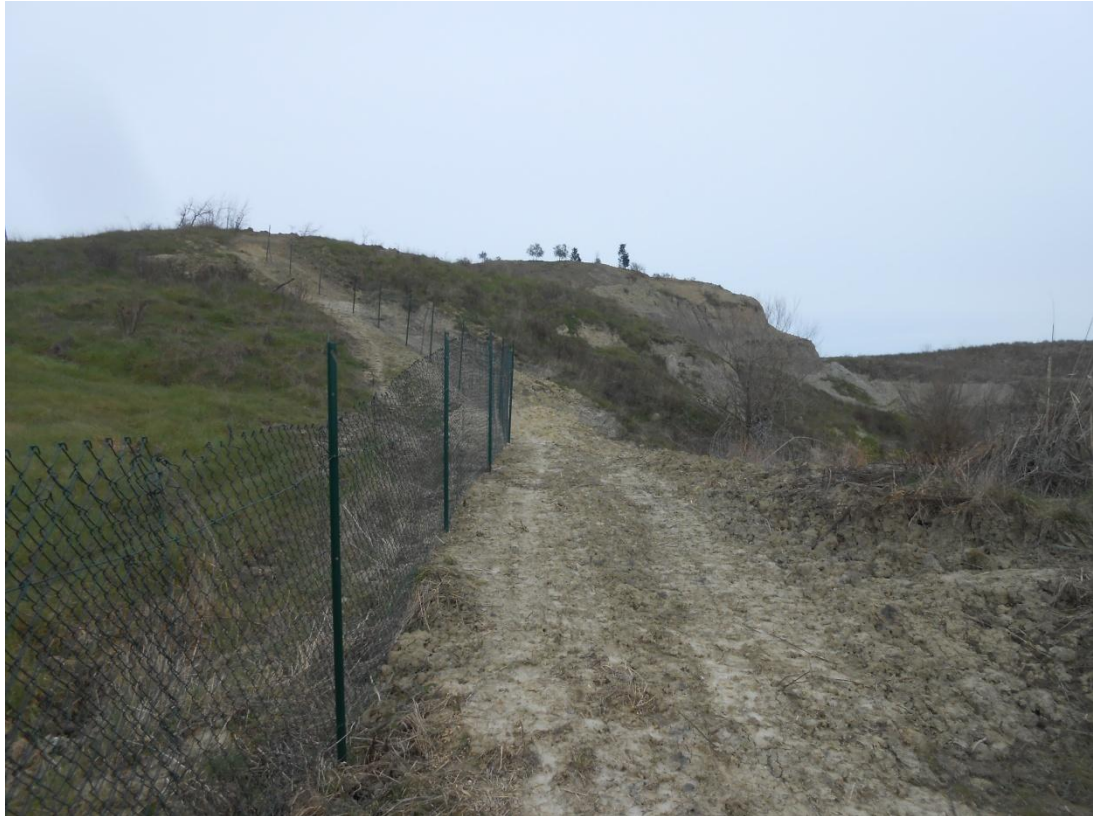
Fig. 9 –Recinzione perimetrale dell'area Ovest
