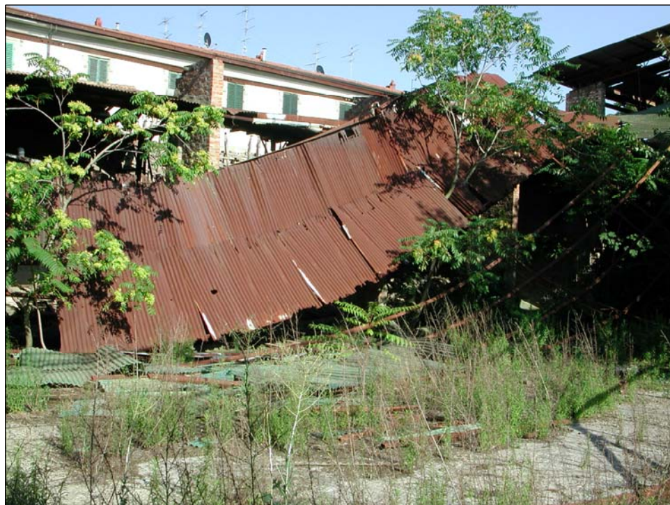
Foto 7 Corte interna lato via G. da Empoli
