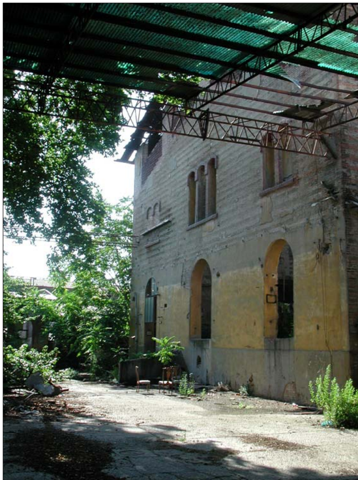
Foto 11 Corte interna lato ingresso
