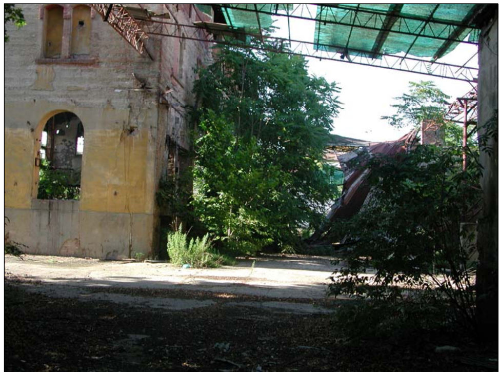
Foto 6 Corte interna lato ingresso
