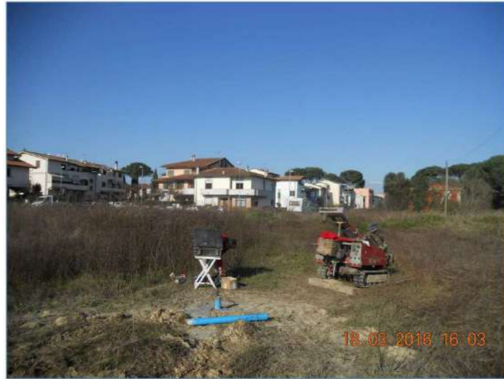
Figura 1: Indagine sismica Down Hole
