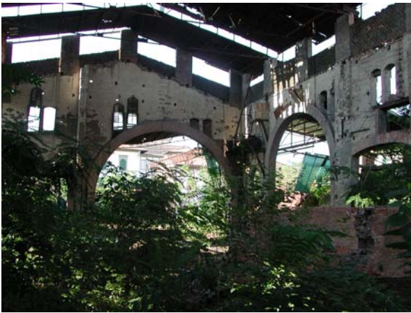
FIGURA 11: EDIFICIO PRINCIPALE VISTA INTERNA
