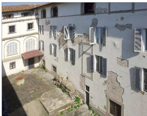
FOTO 1 Vista della corte del Complesso di San Giuseppe con le facciate da rivestire
