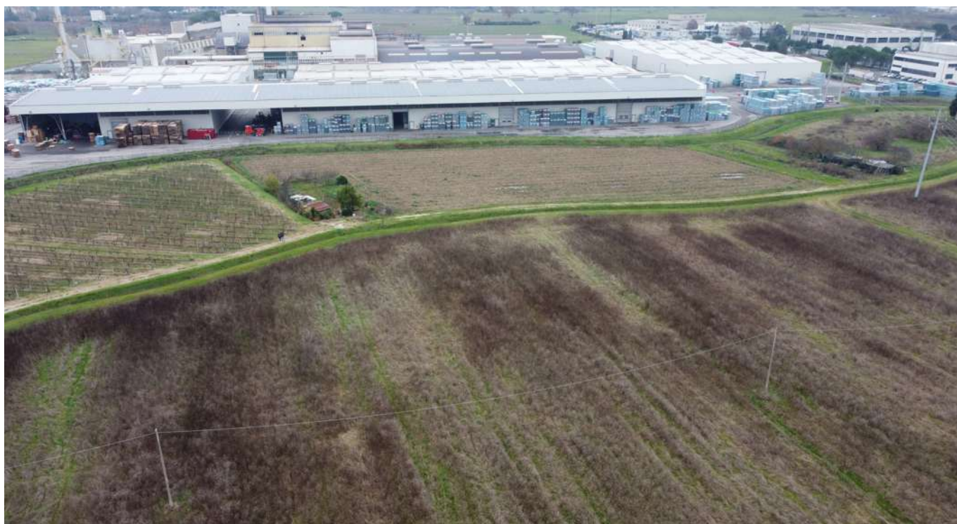
Foto 5: Vista dell'area in cui saranno realizzati gli attraversamenti sul Rio Friano e sul Rio di Pagnana
