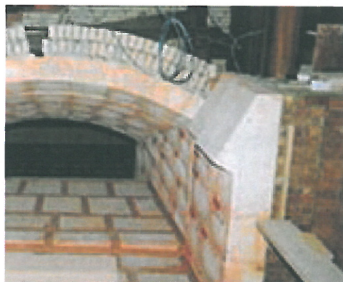
Struttura della volta di un forno del tipo utilizzato nell'impianto di via Salaiola
