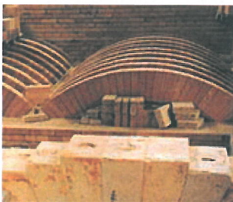
Struttura della volta di un forno del tipo utilizzato nell'impianto di via Salaiola
