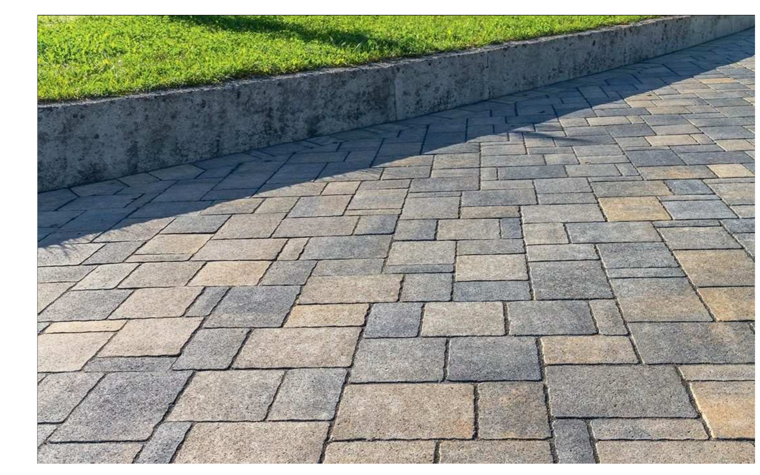
PARTICOLARE NUOVA PAV.NE AUTOBLOCCANTI
