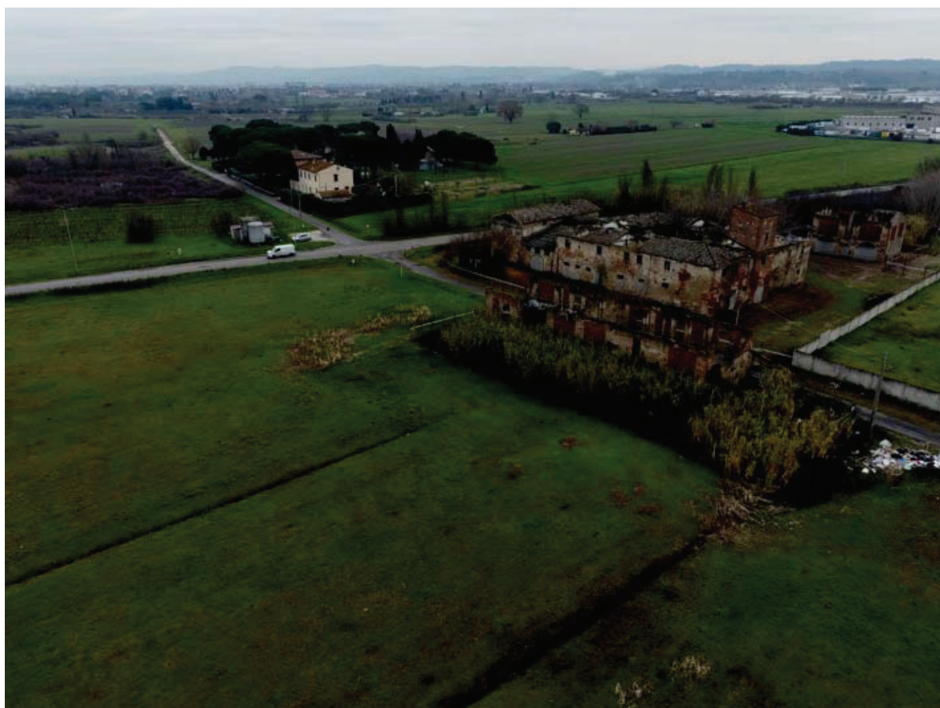
Foto 4: Vista aerea del complesso storico del «Castelluccio».
