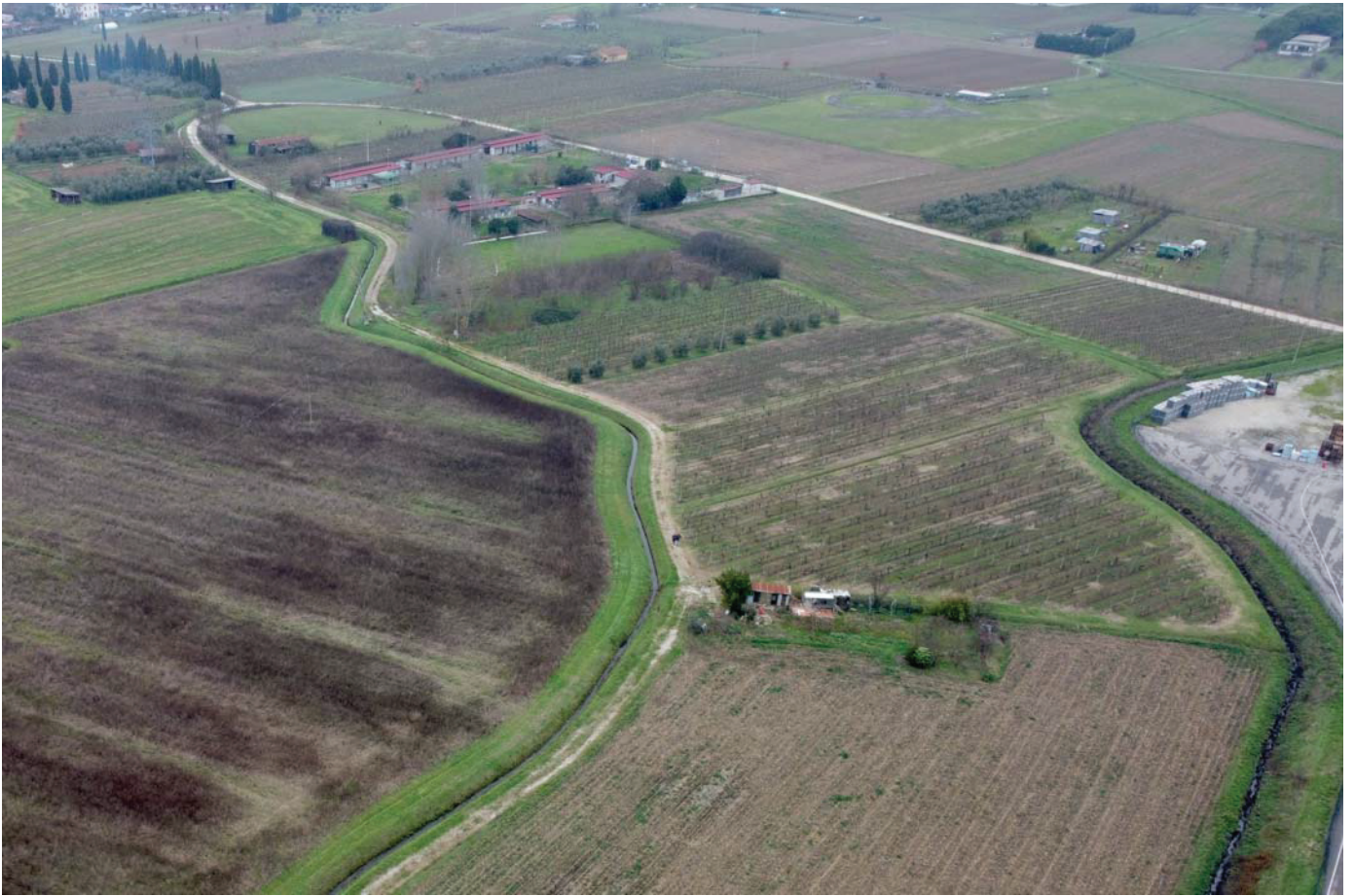
Foto 9: Vista aerea dell'area interessata dalla cassa di compensazione
